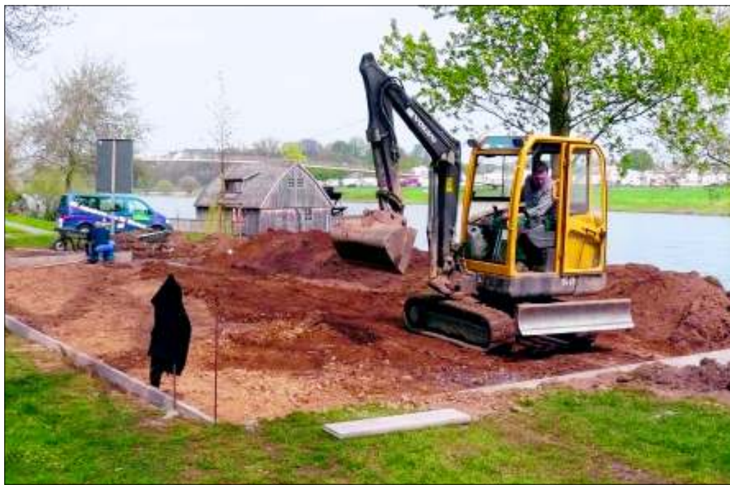
Am vergangenen Wochenende begannen der Verein Schiffmühle und der Lions Club Minden mit der Realisierung des Boule-Platz-Projektes an der Weserpromenade. Die Anlage soll ab Anfang Juni der Öffentlichkeit zur Verfügung gestellt werden. Foto: privat
