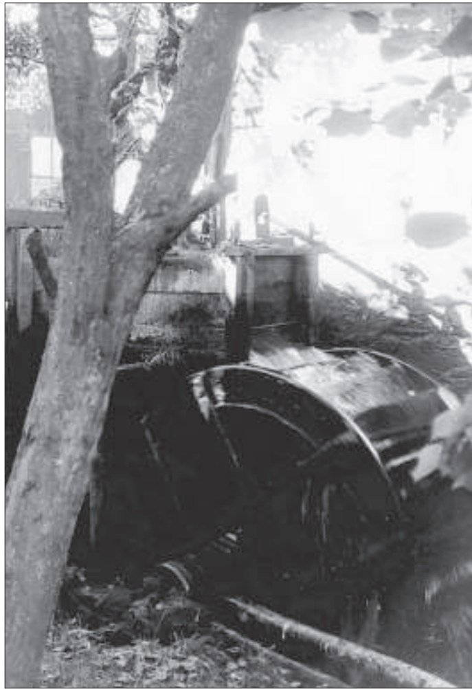
Die Entwicklung der Wassermühle modernisierte die grundherrschaftliche Getreide- und Ernährungswirtschaft in Sachsen. Ober-schlächtiges Wasserrad der Hüffmeierschen Wassermühle in Preußisch Oldendorf 1928/30. Foto: Dieter Besserer
